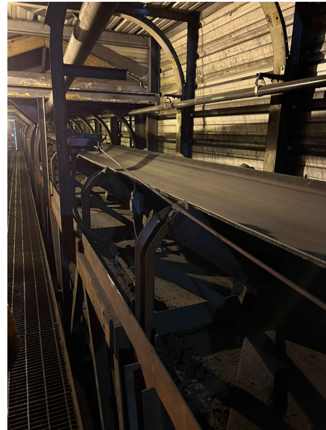
8 DEMO CONVEYOR NO. 2 D2.10
