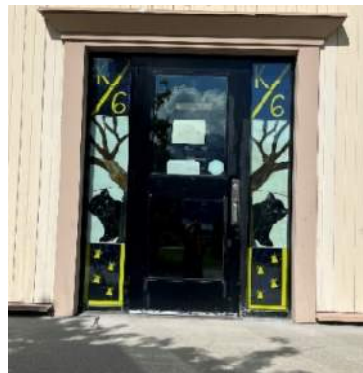
Photo AE20– Door E300, replacement alum door, typ of replacement doors
