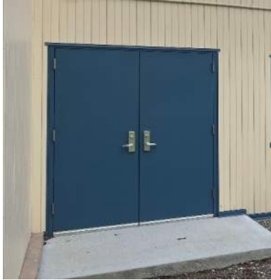
Photo AE21– Door E30A, new HM door, typ of new doors
