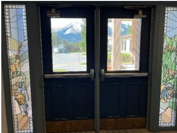
Photo AE17– Door E01, orig HM door, typ of orig doors
