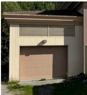
Photo AE22– Door E13C, added coiling OH door
