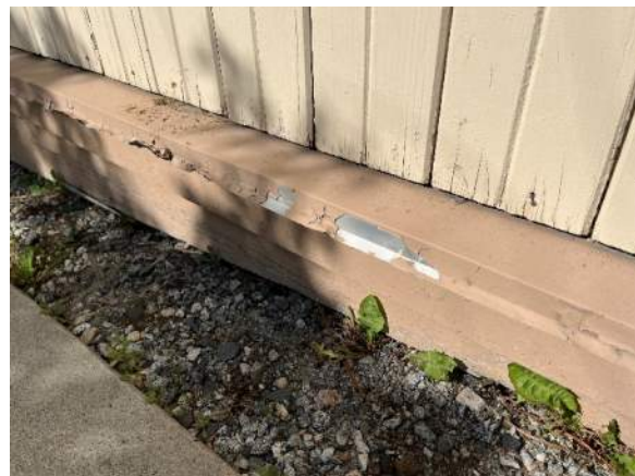
Photo AE07– Orig ext fin cap - water table
